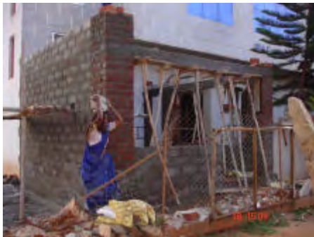
Foto: boekwinkel in aanbouw
